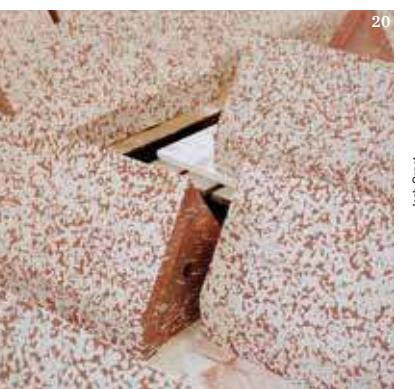
12, 13 la realizzazione dei pilastri in cemento armato pigmentato e composto al 50% da loppa d'altiforno granulata macinata
